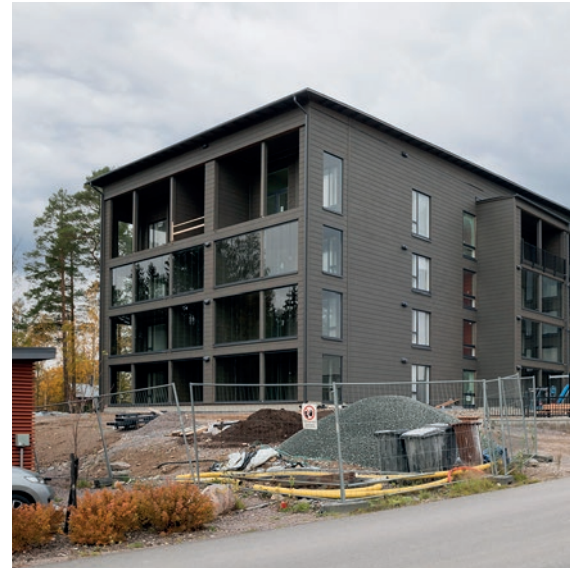
As Oy Sipoon Puuhuippuun toimitettiin 47 A-BEAM®-palkkia.
