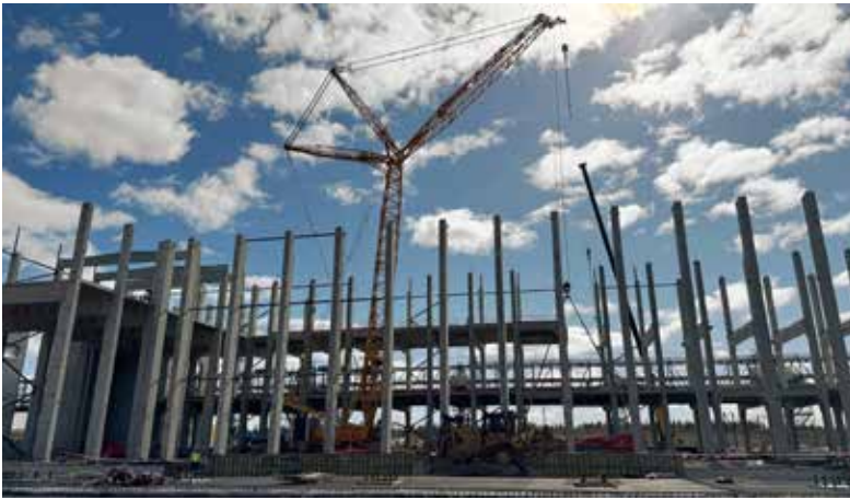
Betonielementtirungon jäykistyksissä on käytetty Anstarin sidejärjestelmiä ja ristikkoliitososia. Kuva: Parma
