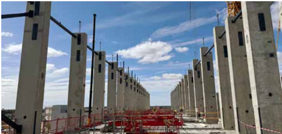
Rakennuksen välitasot toteutetaan kuorilaatoilla ja pintavalulla, ja jännevälit ovat tavanomaista teollisuusrakentamista pidempiä. Varastorakennuksen suurimmat pilarit ovat poikkileikkaukseltaan peräti 1350 x 800 mm maksimipainojen ollessa reilut 60 tonnia. Kuva: Parma
