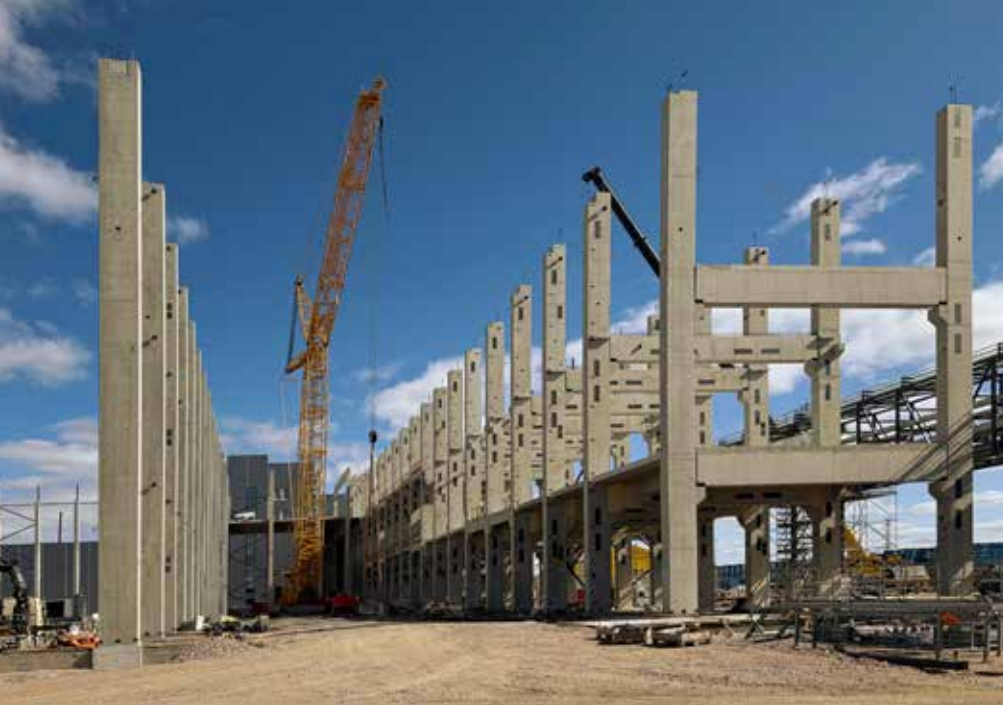
Kotkan akkumateriaalitehtaan varastorakennuksen runko edustaa raskaan teollisuusrakentamisen mittakaavaa. Parman toimittaman betonielementtirungon jäykistyksessä, kiinnityksissä, liitoksissa ja asennuksissa käytetään Anstarin teräsosia. Kuva: Parma
