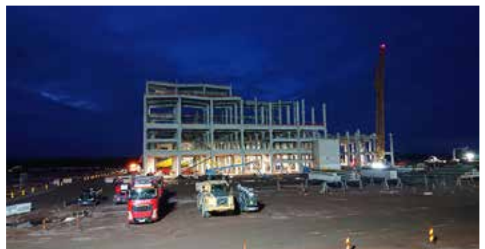
Tuotantorakennuksen runko marraskuussa 2025. Suurimmat pilarit ovat jopa 900 x 900 millimetriä. Kuva: Sweco
