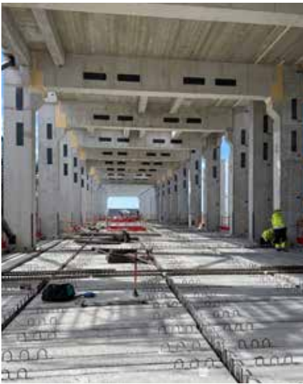
Betoni ja teräs muodostavat akkumateriaalitehtaan varasto-, tuotanto- ja apurakennuksissa tarkasti optimoidun kokonaisuuden. Kuva: Parma
