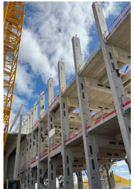
Anstar on toimittanut kohteeseen laajasti Parmalle betonielementteihin myös muita teräsosia, kuten kiinnitys- ja liitososia sekä pilarikenkiä. Kuva: Parma
