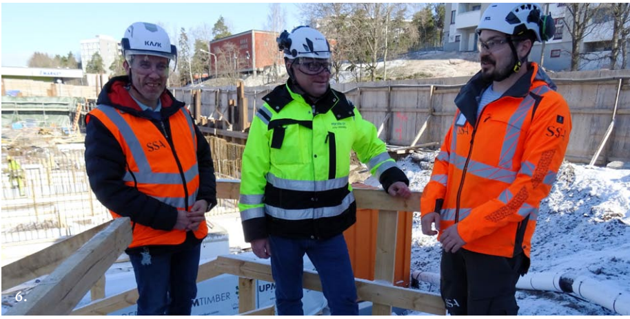
Kuva 6: SSA:n Jarmo Rautakoski (vas) ja Otto Hermunen sekä Pektran Jussi Taskinen olivat tyytyväisiä työmaan etenemiseen.
